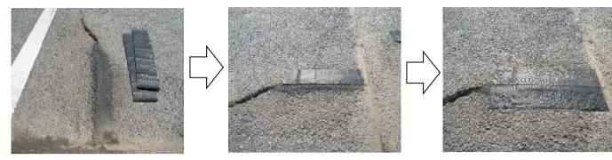
③エースパッチ水硬型が十分硬化し、アスファルト面が乾いてから エムケイテープを張り付ける。
