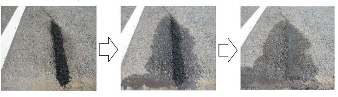
②施工箇所にエースパッチ水硬型を投入し、水をかけて転圧する。
