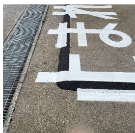
乗り入れ部補修
