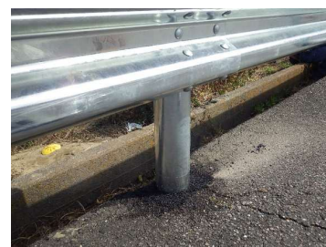
支柱回り復旧
